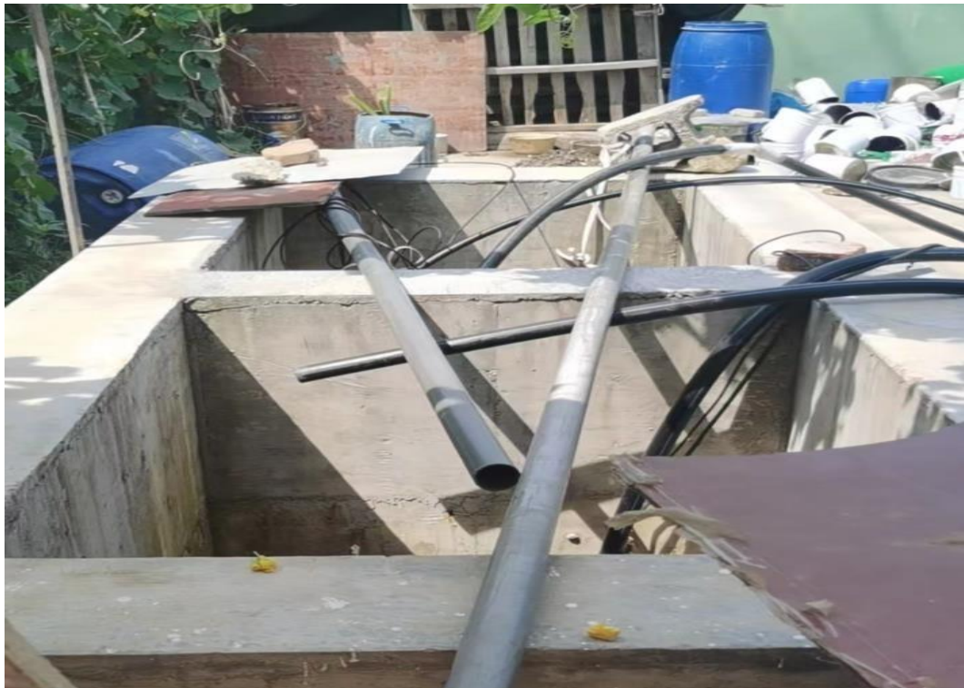
事故池和初期雨水池
