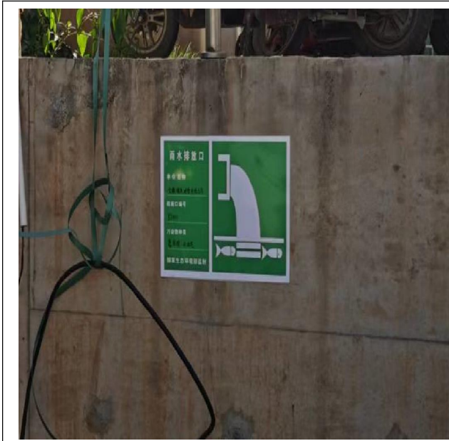
雨水排放口标识牌
