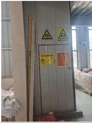
危险固废暂存间
