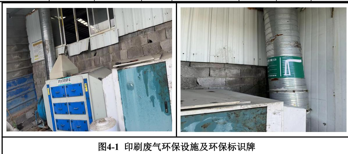
图4-1 印刷废气环保设施及环保标识牌
