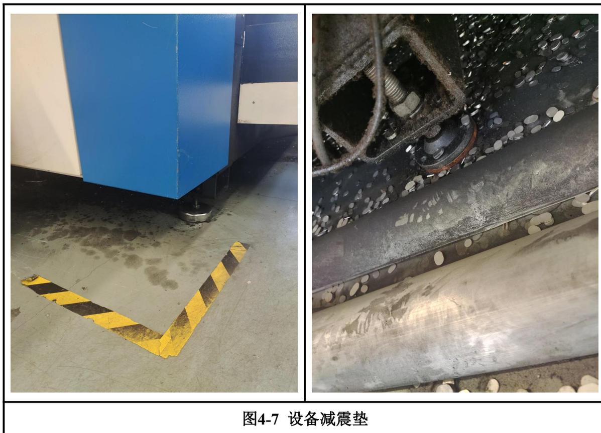
图4-7 设备减震垫
