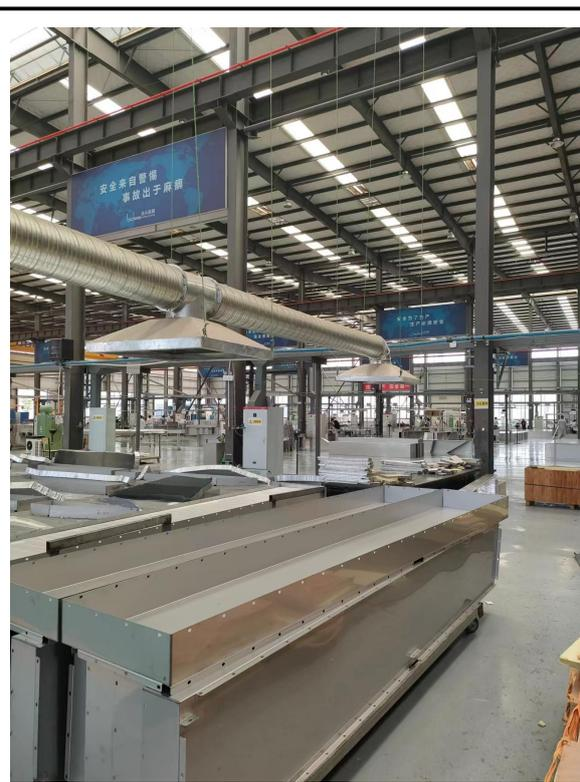
图4-4 A4车间有机废气收集设施
