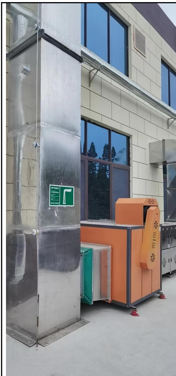
图4-4 静电式油烟净化器
