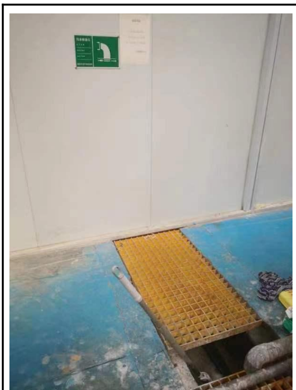
图4-1 化粪池及污水排口
