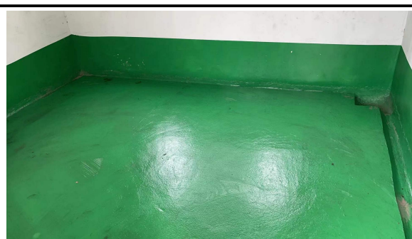
图4-7 危废间防渗地面
