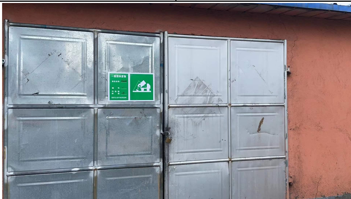
图4-10 一般固废暂存间
