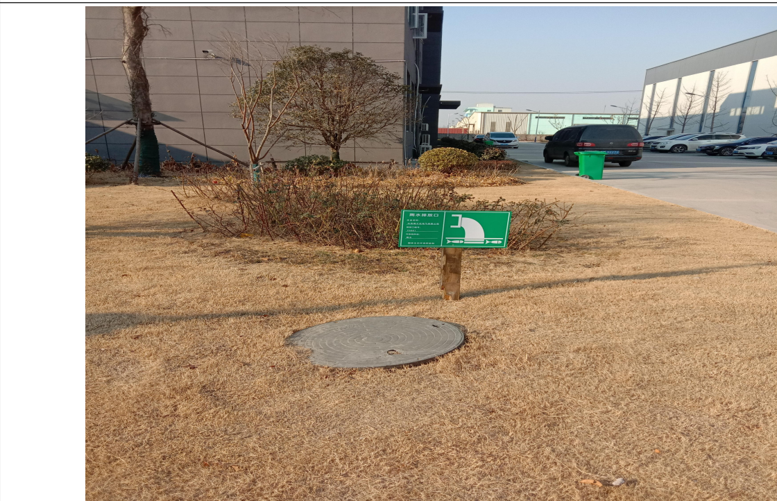
图 4-1 化粪池及雨水排放口
