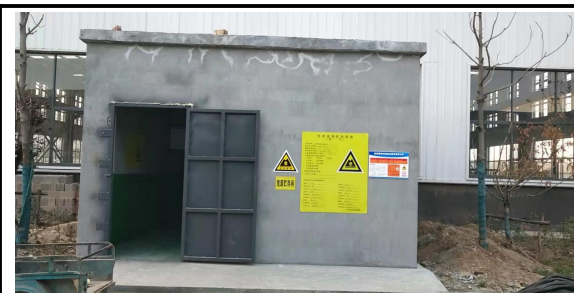
图4-8 危废暂存间门口
