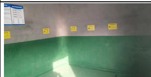
图4-10 危废暂存间标识牌
