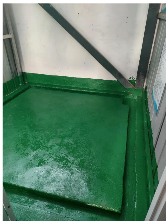
图4-7 危废间防渗地面
