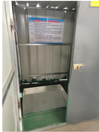
危险固废暂存间
