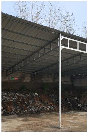
一般固废暂存间
