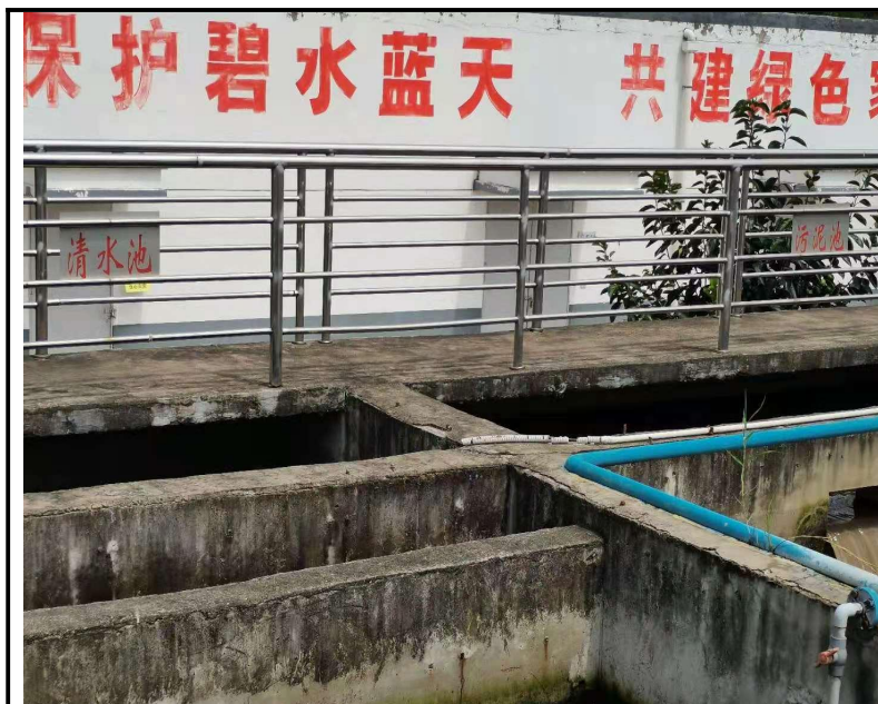
图4-5 清水池、污泥池
