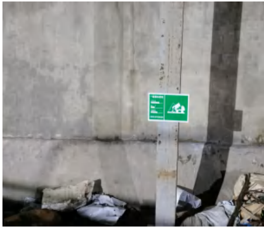
一般固废暂存间
